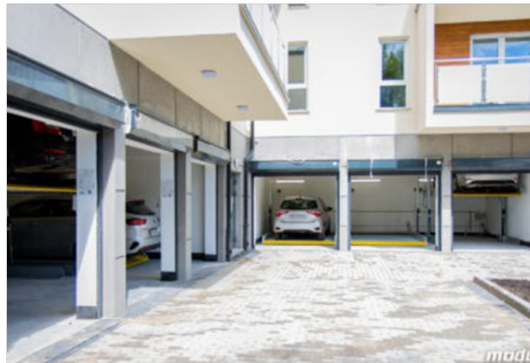
Budynek wielorodzinny Bydgoszcz - Platformy zależne Modulo Stacker-P10, 18 miejsc parkingowych
