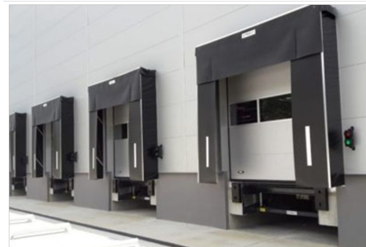
Hala produkcyjna i magazynowa w Kietrz
