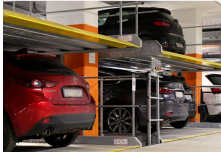
Szpital Gdańsk - Platformy parkingowe niezależne MODULO Parker-C100 – 20 miejsc parkingowych.
