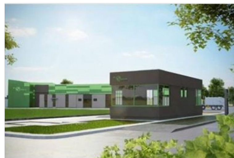
Stacja Przetadunkowa Odpadów w Toruniu
